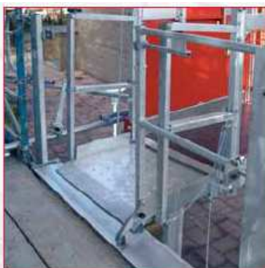
Poloha nakládací rampy dl.60cm při výstupu z plošiny v patře lešení
