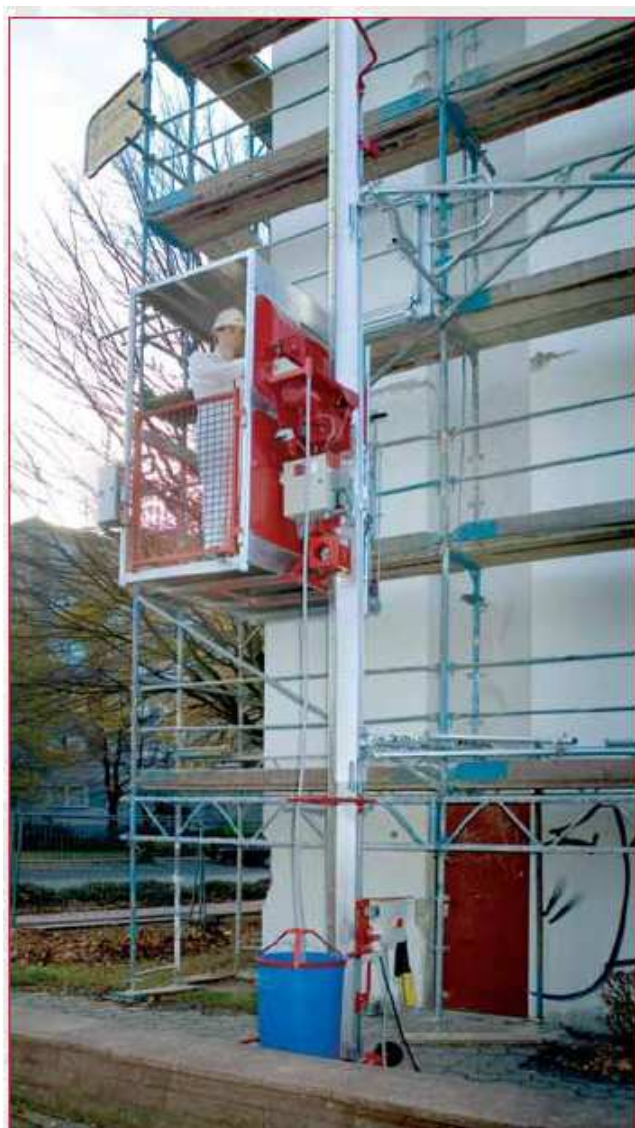
Dveře s elektro-mechanickým jištěním na vstupní straně plošiny a sklopná nakládací rampa s elektro-mechanickým jištěním na výstupu
